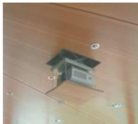
Detail Beamer Stadtwerke Bielefeld
